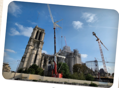
공사중인 노트르담 대성당
